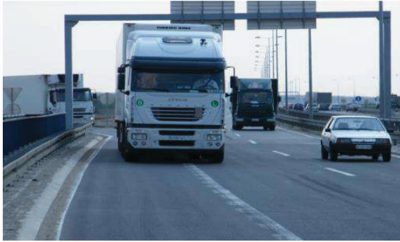
Слика 12.4 – Преуска трака за убрзавање (АБС, 2017)
