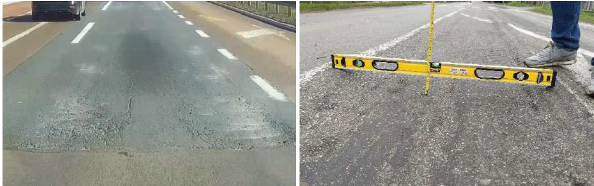
Слика 11.44 – Примери улегнућа коловоза
