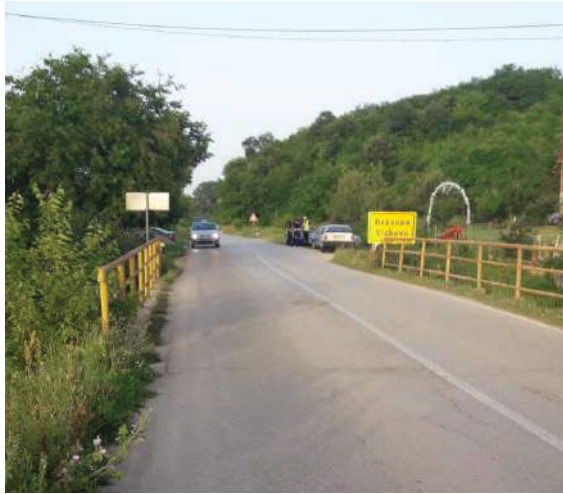
Слика 14.104 – Небезбедна заштитна ограда на мостовима
