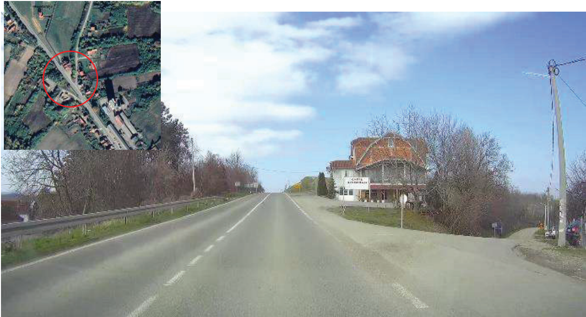
Слика 11.14 – Пример небезбедне четворокраке „Y“ раскрснице
