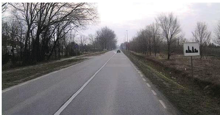
Слика 11.3 – Пример неусклађене границе зоне насеља са окружењем пута (ЈП „Путеви Србије“, 2022.)
