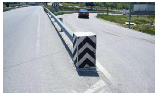
Слика 12.24 – Опасан почетак заштитне оgrade (АБС, 2017)
