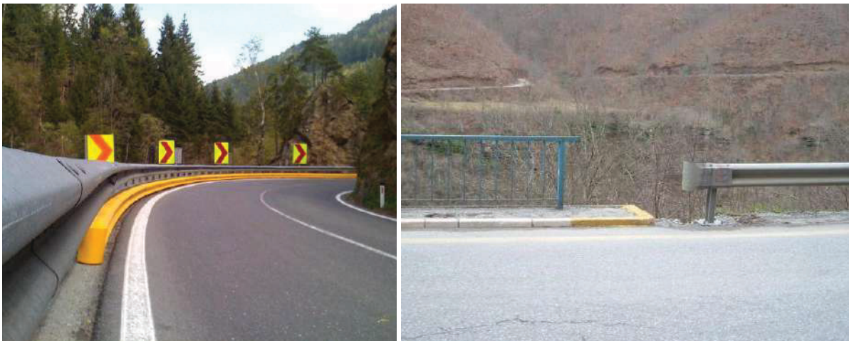
Слика 11.37 – Пример додатне ламеле за мотоциклисте (лево) и проблем постојања „прозора“ у заштитним оградама (десно)
