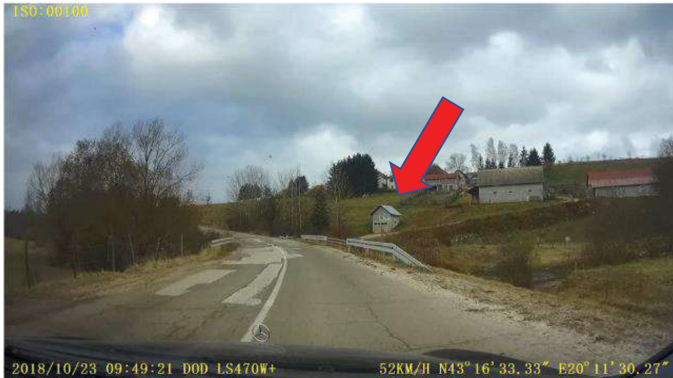
Слика 15.22 – Зона моста (снимак са терена)
