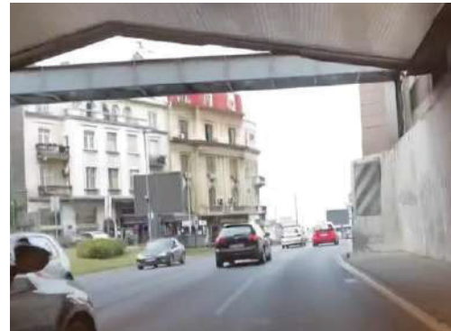
Слика 12.31 – Присуство незаштићеног објекта на излазу из тунела
