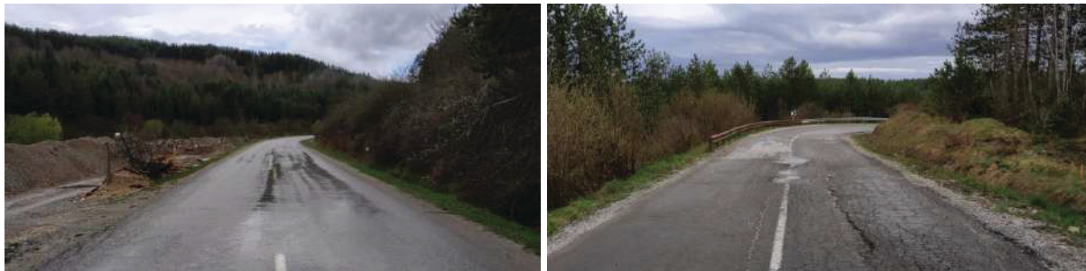
Слика 11.13 – Места са повећаном могућношћу настанка леда и поледице на путу због задржавања воде и повећане влажности
