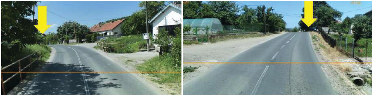
Слика 11.39 – Аутобуско стајалиште у хоризонталној и вертикалној кривини
