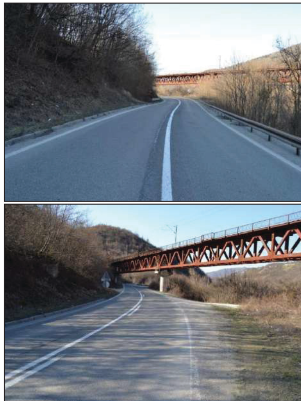
Слика 14.32 – Примена минималних радијуса узастопних кривина због путног објекта
