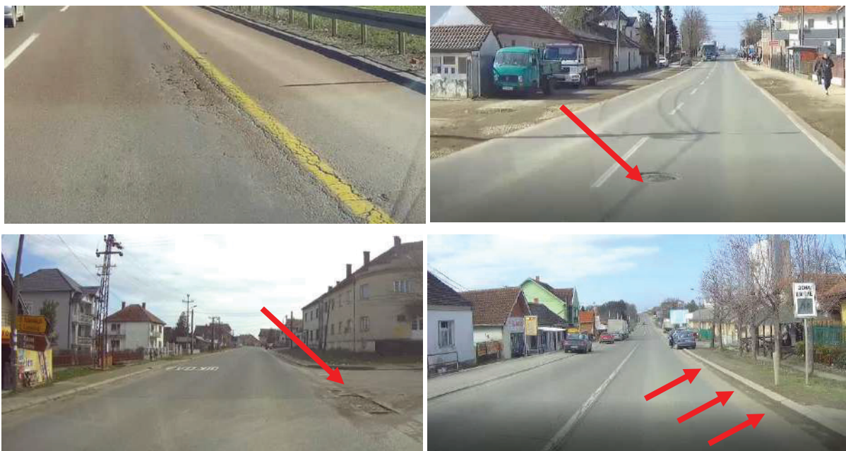
Слика 11.45 – Примери оштећења и запрљаности коловоза
