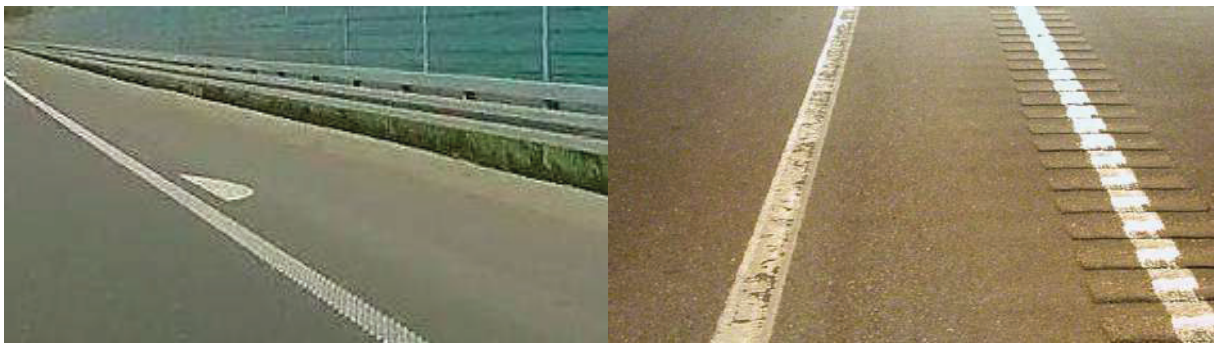
Слика 14.93 – Вибро-акустична трака са термопластиком и усецањем
