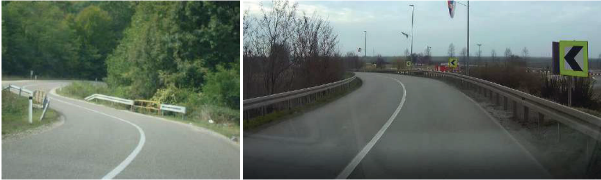
Слика 11.34 – Неадекватно обележена опасна кривина (лево) и изглед могућег решења (десно)
