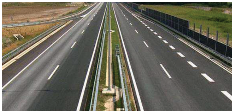
Слика 14.11 – Попречни профил ауто-пута са коловозним тракама, разделном траком, зауставном траком и траком за убрзавање
