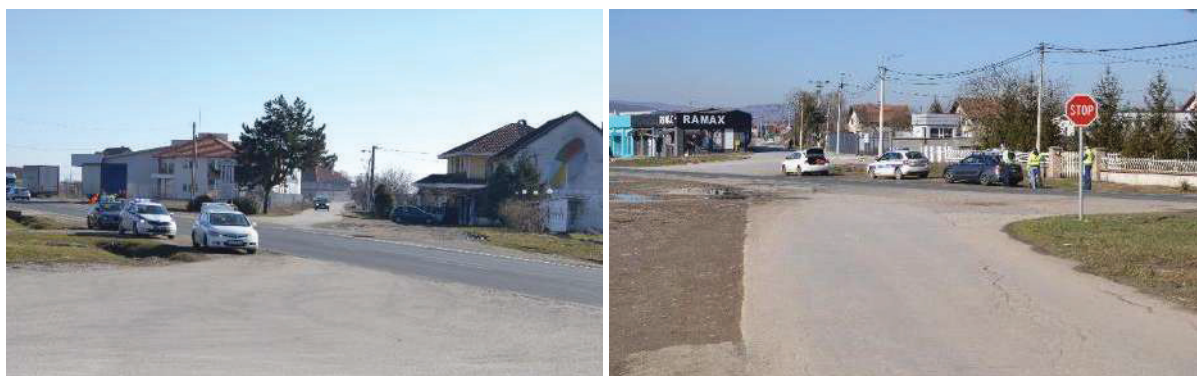
Слика 14.51 – Примери раскрснице неправилног геометријског облика – сакнуте раскрснице
