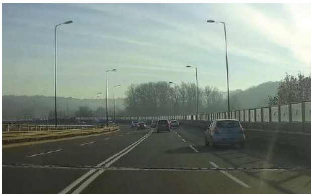
Слика 14.36 – Већи подужни и недовољан попречни нагиб, место превођења воде преко коловоза у хоризонталним кривинама
