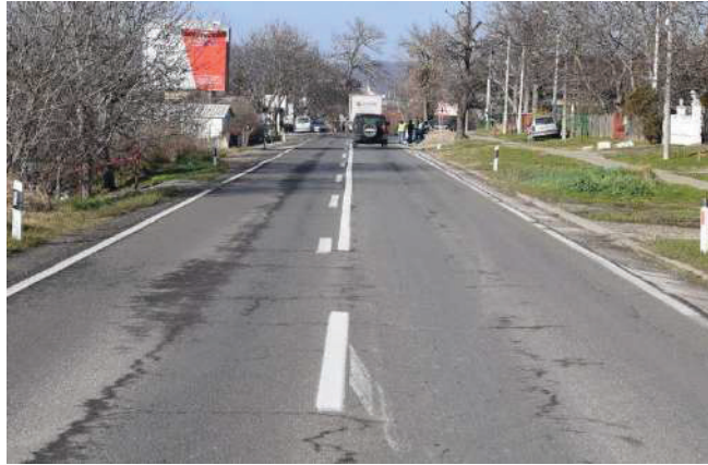
Слика 14.22 – Пролазак државног пута кроз насеље без промене профила саобраћајнице
