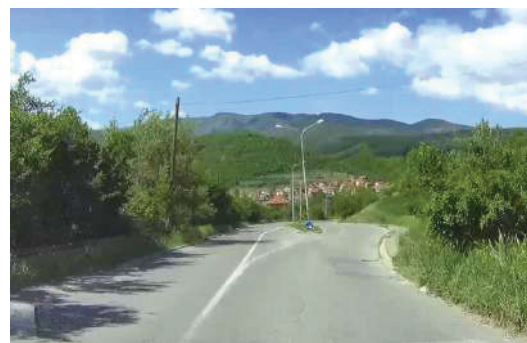
Слика 12.19 – Погрешно и недовољно означавање пружања пута (ЈП за државне путеве Северне Македоније, 2017)
