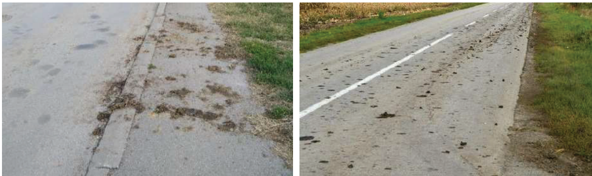
Слика 11.17 – Пример наноса блато на коловозу
