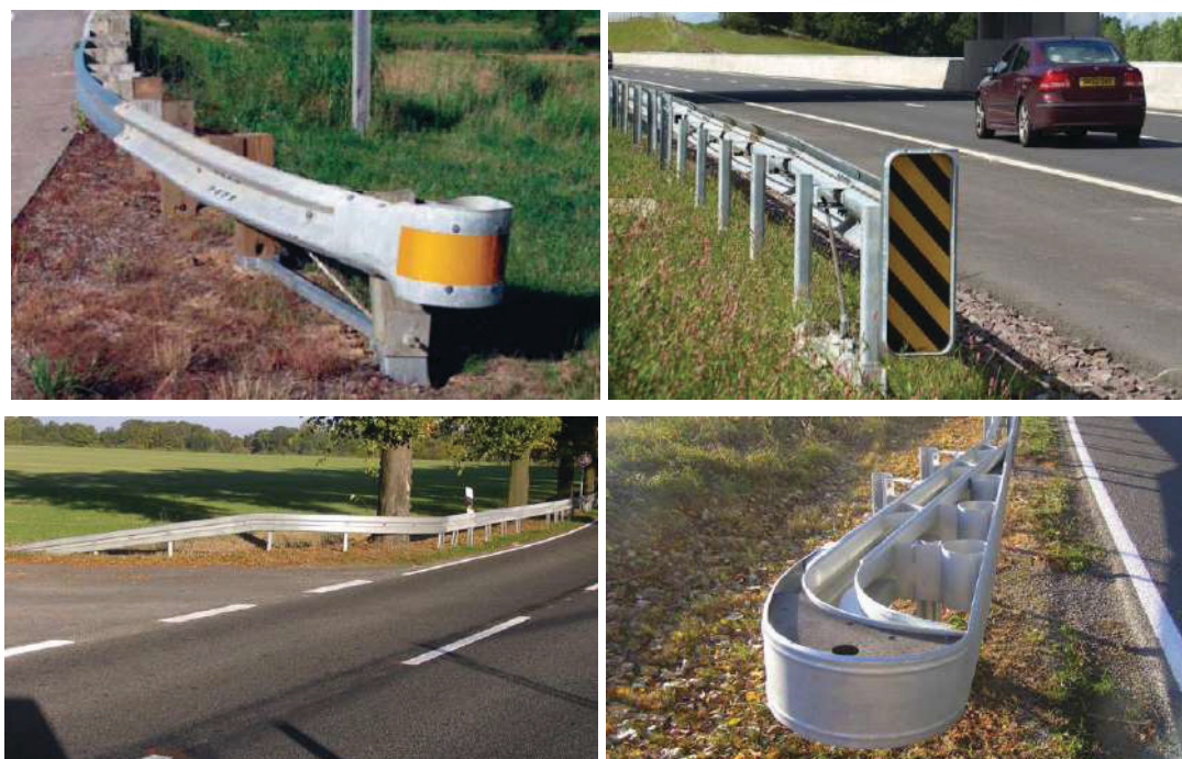
Слика 11.41 – Модели извођења крајева еластичне одбојне ограде
