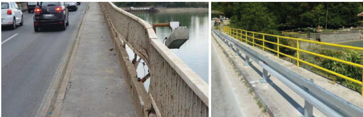
Слика 11.47 – Недостатак еластичне заштитне ограде и оштећена пешачка ограда (лево) и пример заштитних ограда на мосту (десно)
