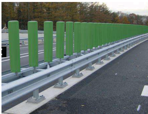
Слика 15.27 – Предлог решења опрема против заслепљивања возача
