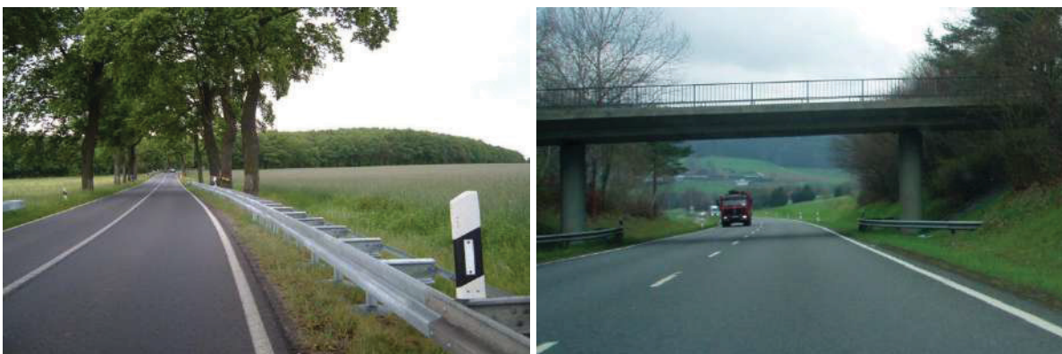
Слика 11.43 – Заштита дрвореда поред пута (лево) и бетонских стубова моста (десно) (АБС, 2021.)
