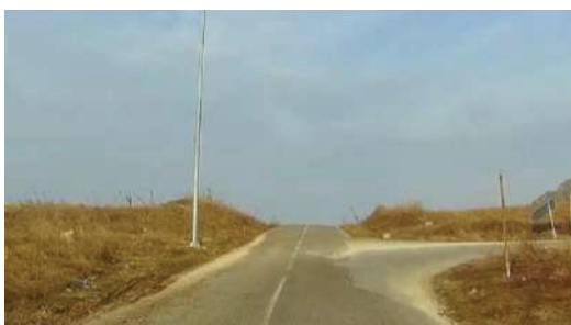
Слика 12.10 – Небезбедна комбинација превоја пута и раскрснице (ЈП за државне путеве Северне Македоније, 2017)
