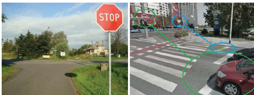
Слика 11.31 – Недостатак елемената хоризонталне сигнализације (лево) и неусаглашеност сигнализације (десно) (АБС, 2017.)
