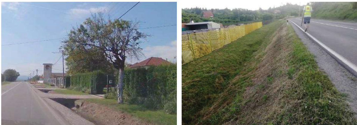
Слика 14.98 – Пасивно небезбедни одводни канали око пута
