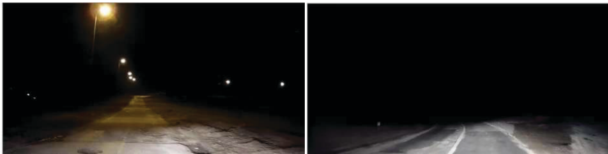
Слика 11.27 – Пример неадекватног осветљења (лево) и непостојања осветљења (десно) (АБС, 2017)
