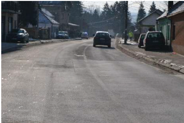
Слика 14.23 – Велика ширина коловоза на проласку државног пута кроз насеље
