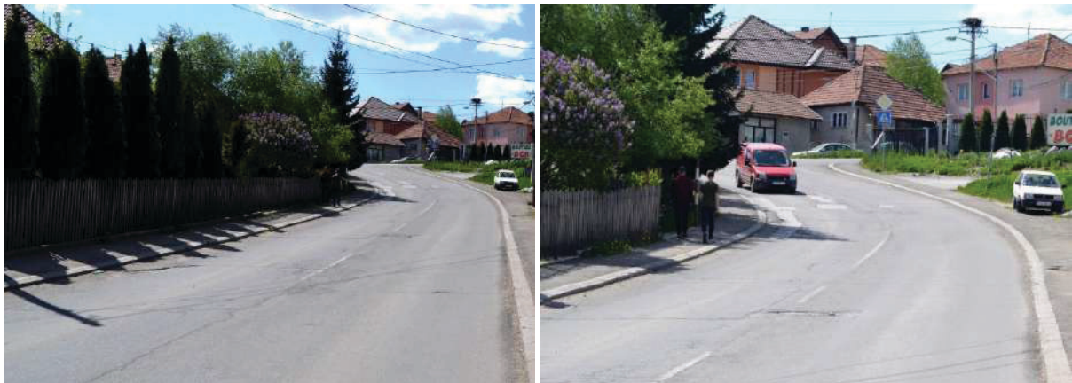
Слика 14.41 – Немогућност уочавања пружања трасе пута након превоја где се налази неправилна четворокрака раскрсница и значајна промена подужног нагиба пута
