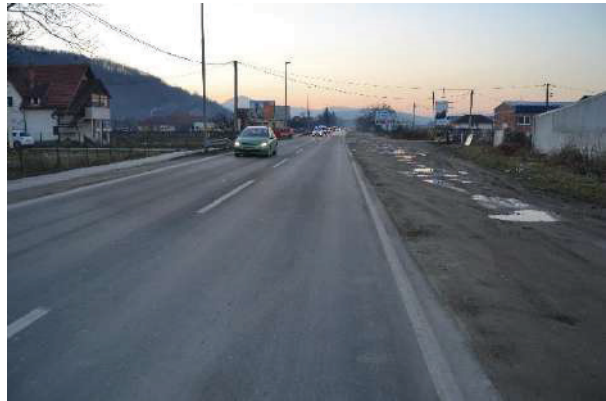
Слика 14.23 – Велика ширина коловоза на проласку државног пута кроз насеље
