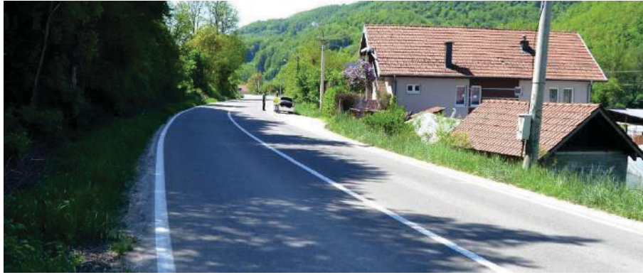
Слика 14.35 – Прелазне кривине велике дужине
