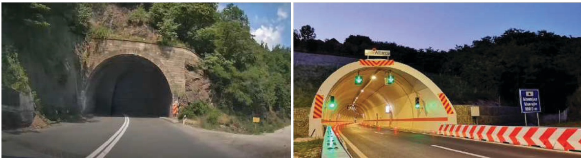
Слика 11.46 – Неосветљен тунел са чврстим препрекама на улазу (лево) и осветљен тунел (десно)
