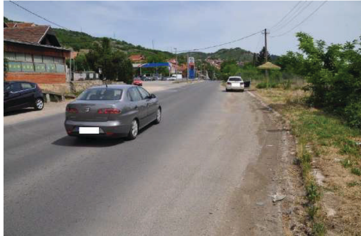
Слика 14.74 – Пример аутобуског стајалишта у насељу на којем није регулисано вођење пешака, такође недостаје саобраћајна сигнализација и осветљење
