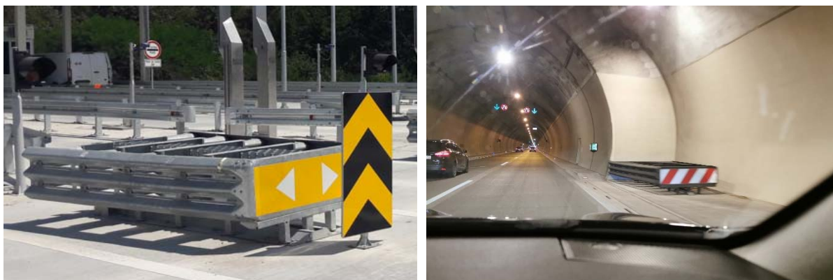
Слика 14 – Пример пригушивача удара
