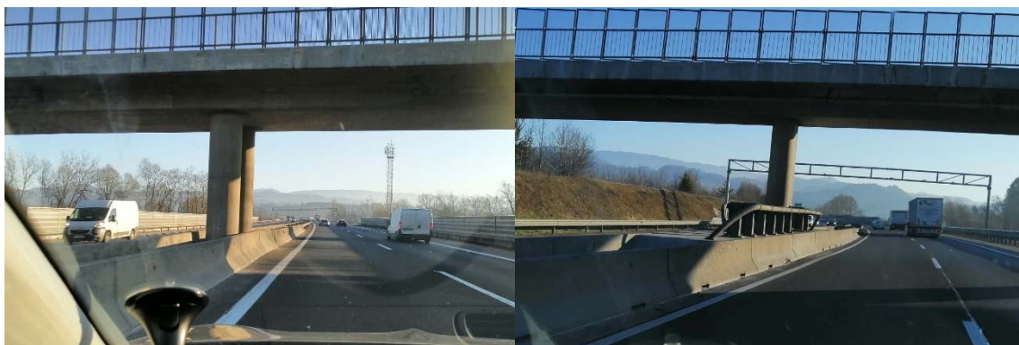
Слика 19 – Пример лошег (лево) и доброг (десно) система за задржавање возила
