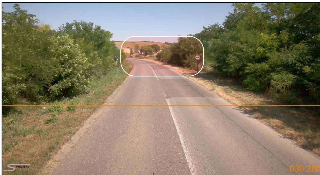
Слика 5.2. Небезбедна забрана претицања непосредно пре почетка хоризонталне кривине
